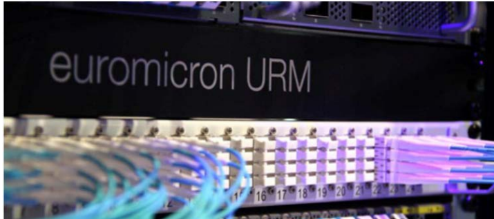
Foto 1: Mit der euromicron LWL-Steckverbinder URM sind bis zu 192 Fasern pro HE möglich
