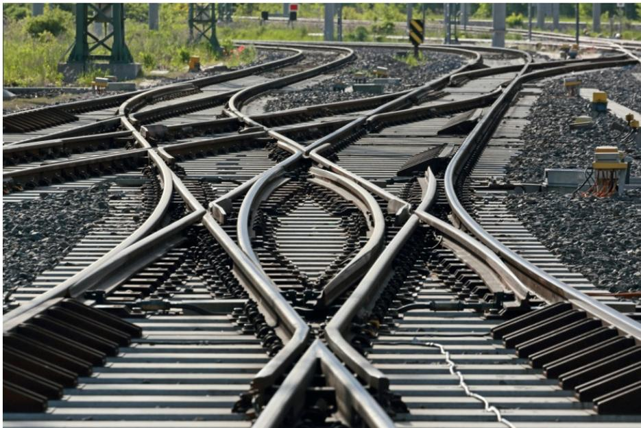
Foto: Doppelte Gleisverbindung im Bahnhof Weimar mit einer doppelten Kreuzungsweiche
